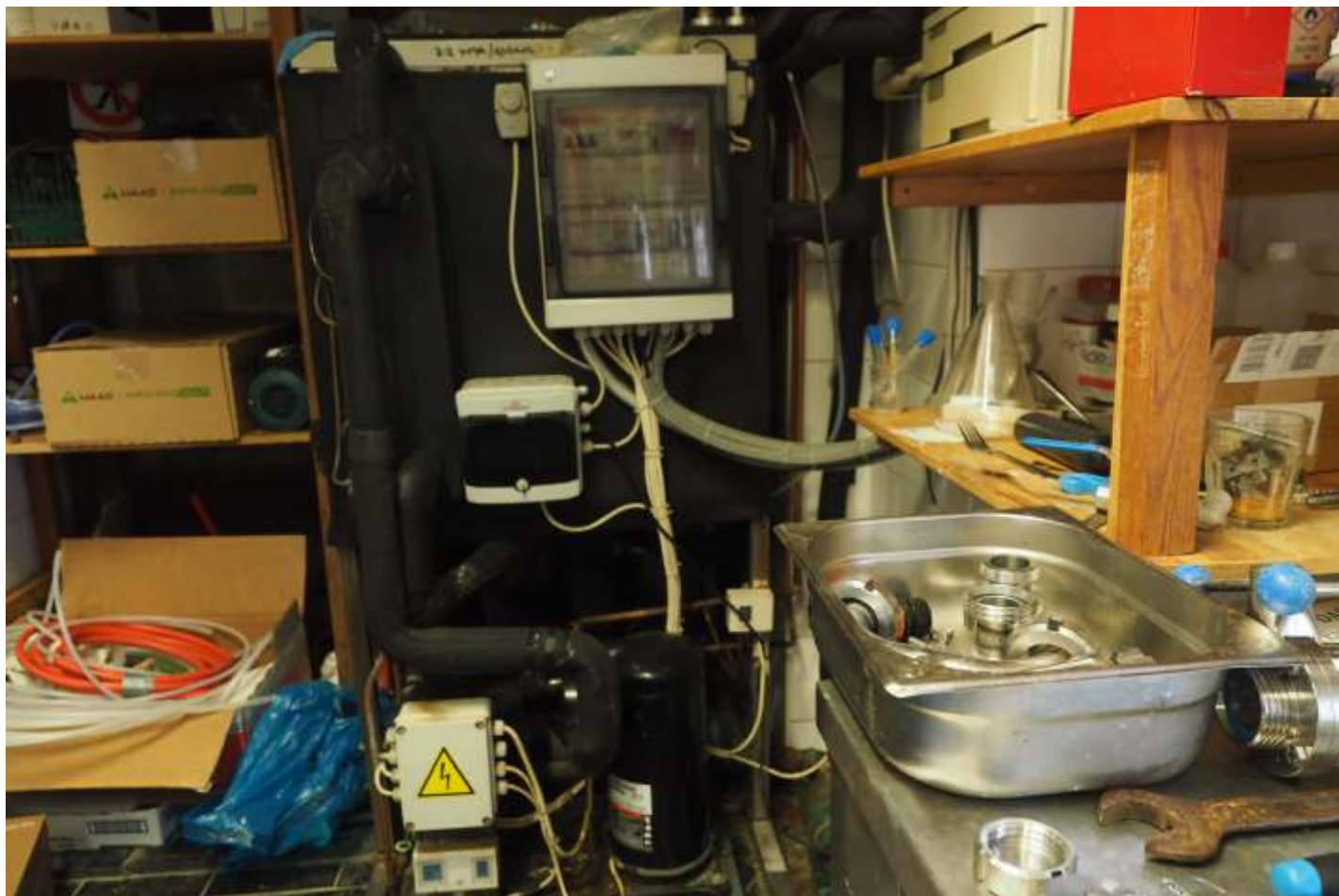
výrobník chladu s nádobou na glykol
